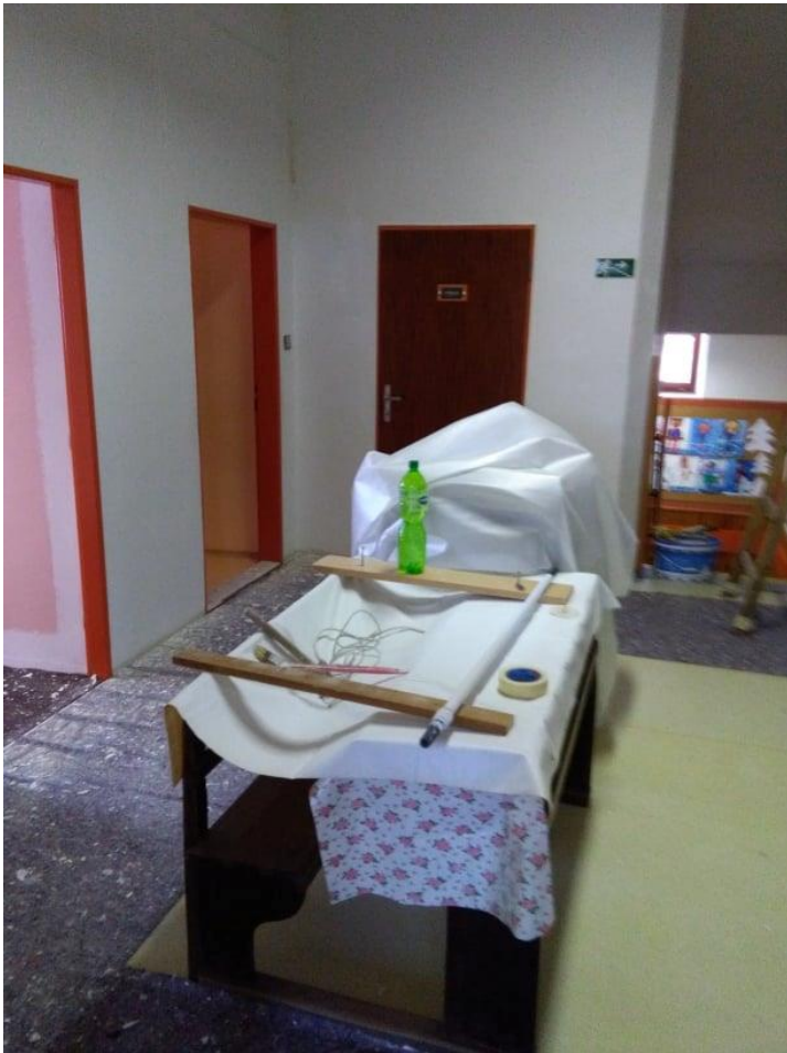
Historický koutek ve 2NP budovy ZŠ během rekonstrukce
