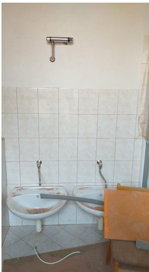
Hygienická kabina v budově ZŠ během rekonstrukce
