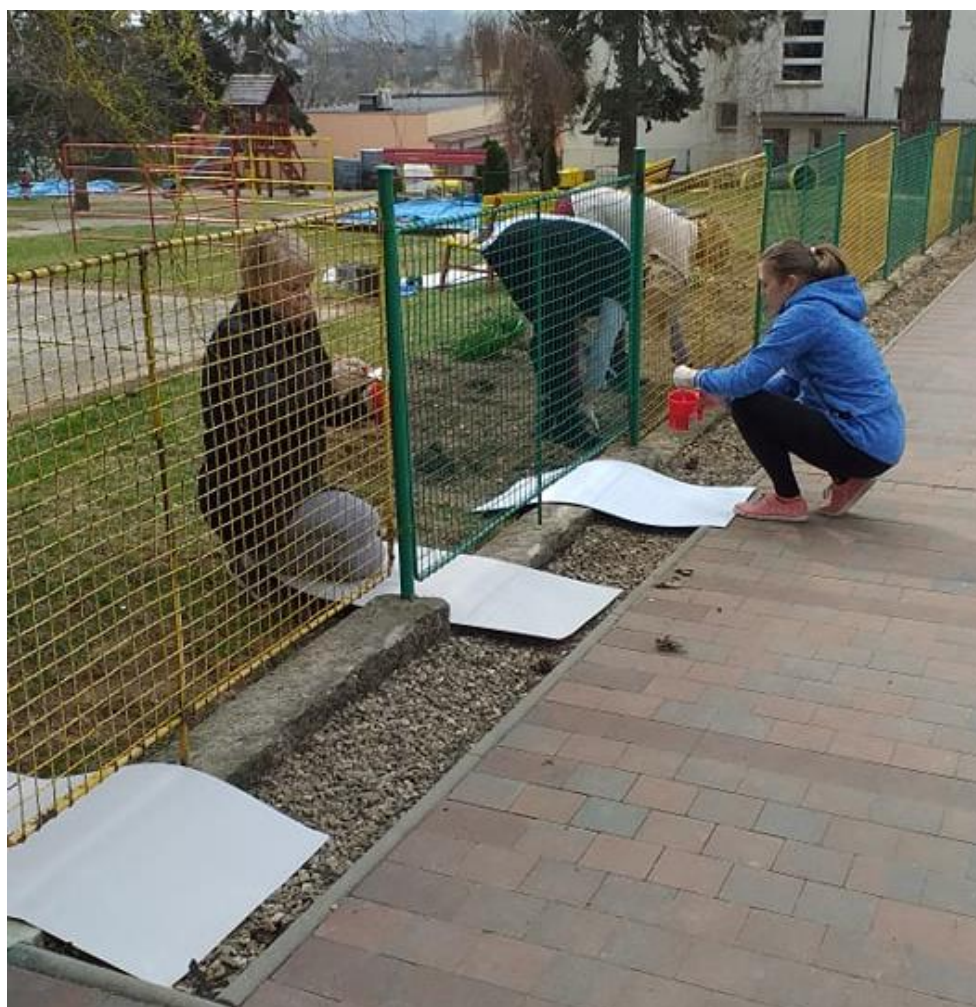
Plot u MŠ během rekonstrukce
