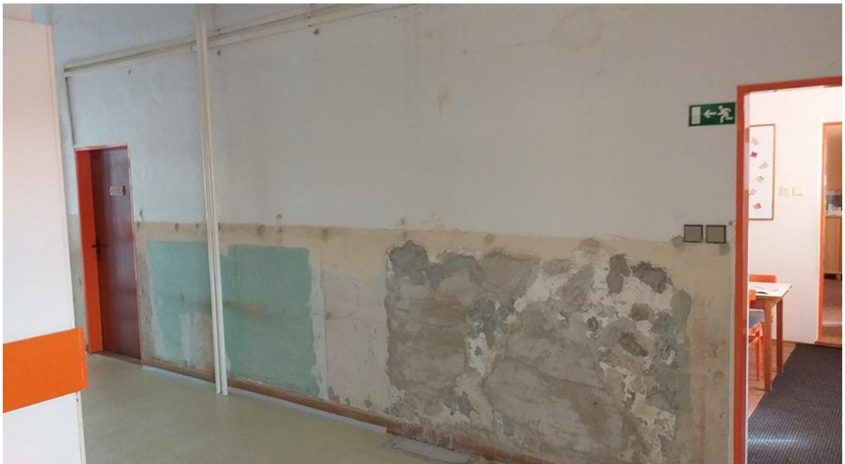
Vstupní prostory během rekonstrukce
