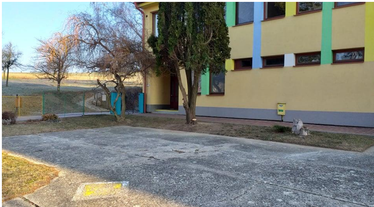
Betonová plocha před MŠ – dříve
