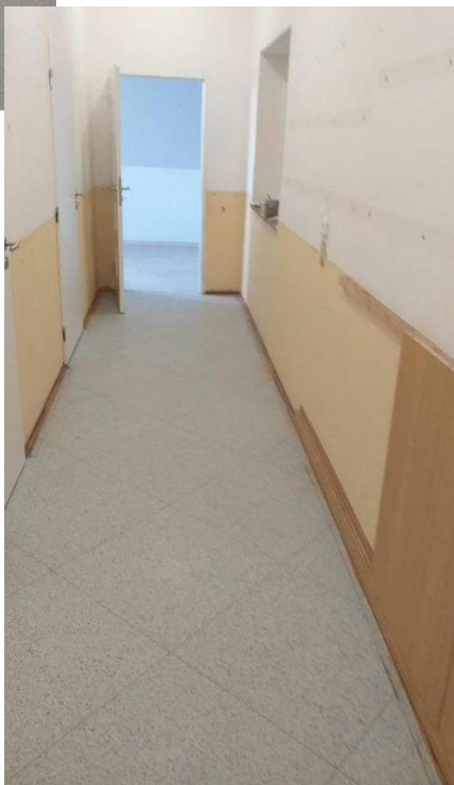
Chodba do třídy Motýlci během rekonstrukce
