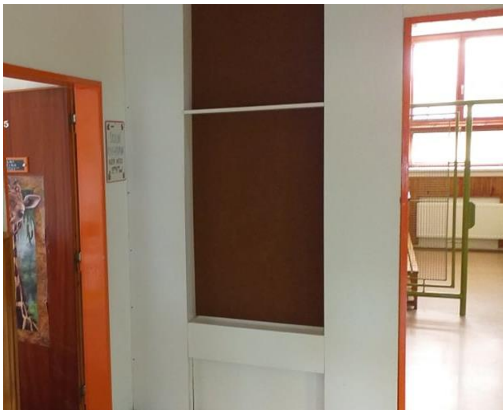
Vstupní prostor dříve (pohled směrem k místní Sokolovně)
