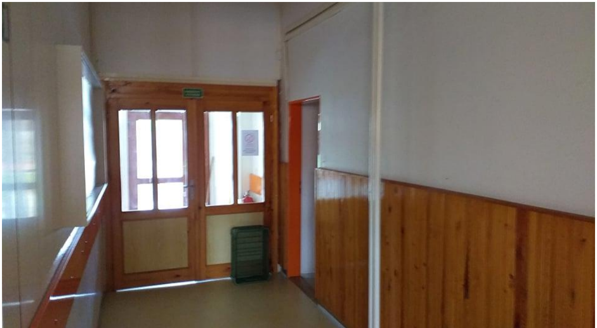
Vstupní prostory v budově ZŠ dříve (pohled k centru obce)
