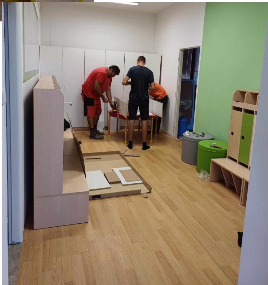
Šatna třídy Berušky během rekonstrukce
